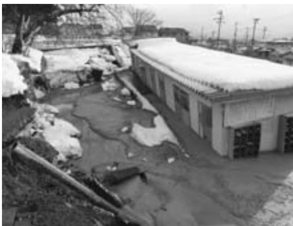
写3 液状化により沈んだプール機械室
