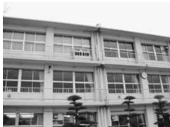
校舎継ぎ目の大きな亀裂
