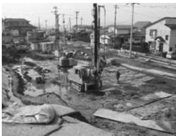
地盤を固めるための工事
