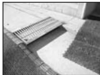
日陰で確認できる体育館南側の地盤沈下（ここでトイレの下水配管亀裂発生）
