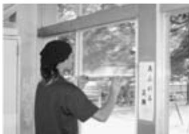
7月21日～22日の2日間をかけて普通教室に遮熱フィルムの施工工事が実施された。太陽光による紫外線・赤外線及び熱を遮断するものである。
